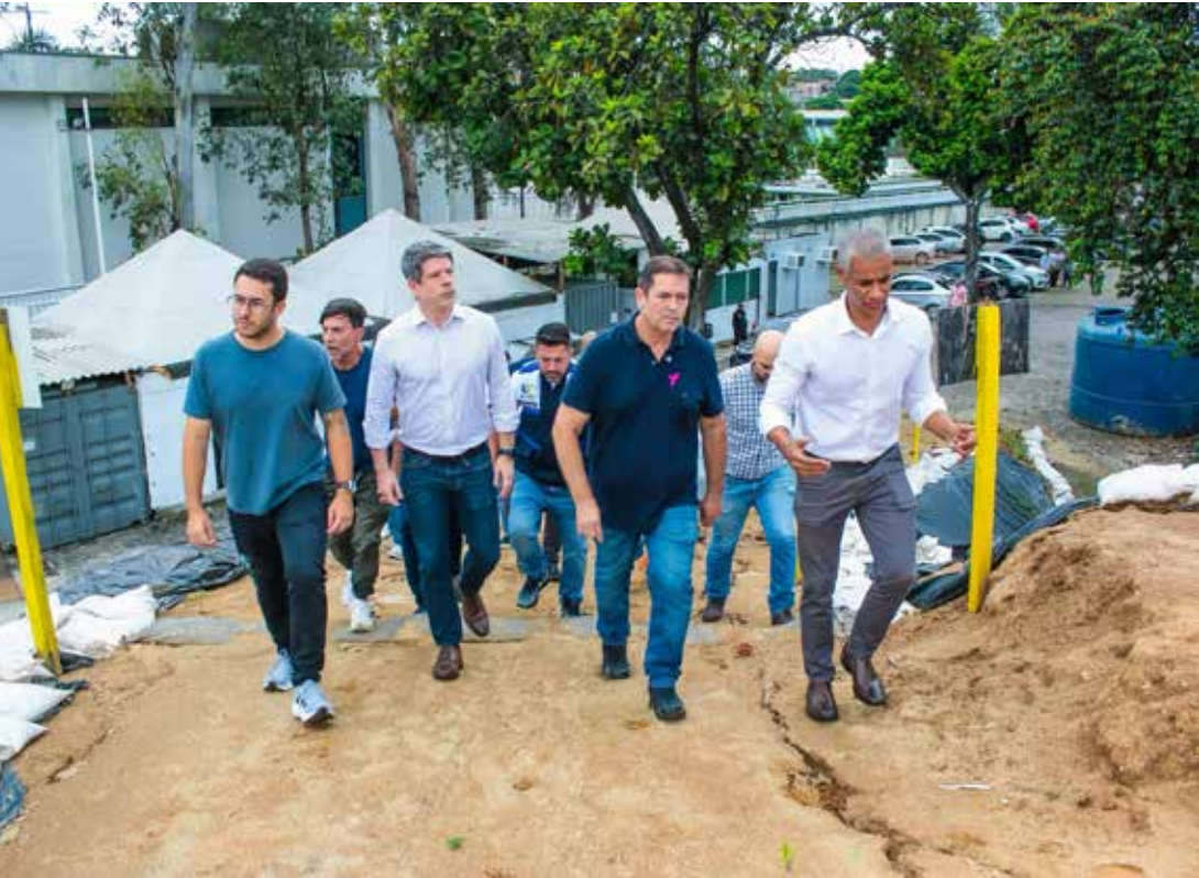
Autoridades visitaram o andamento das obras históricas de mobilidade urbana na cidade
