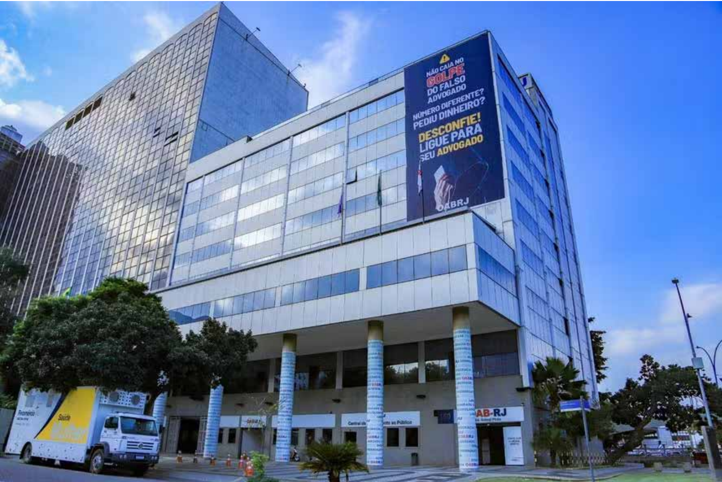
A sede da OAB-RJ, no Centro do Rio de Janeiro
