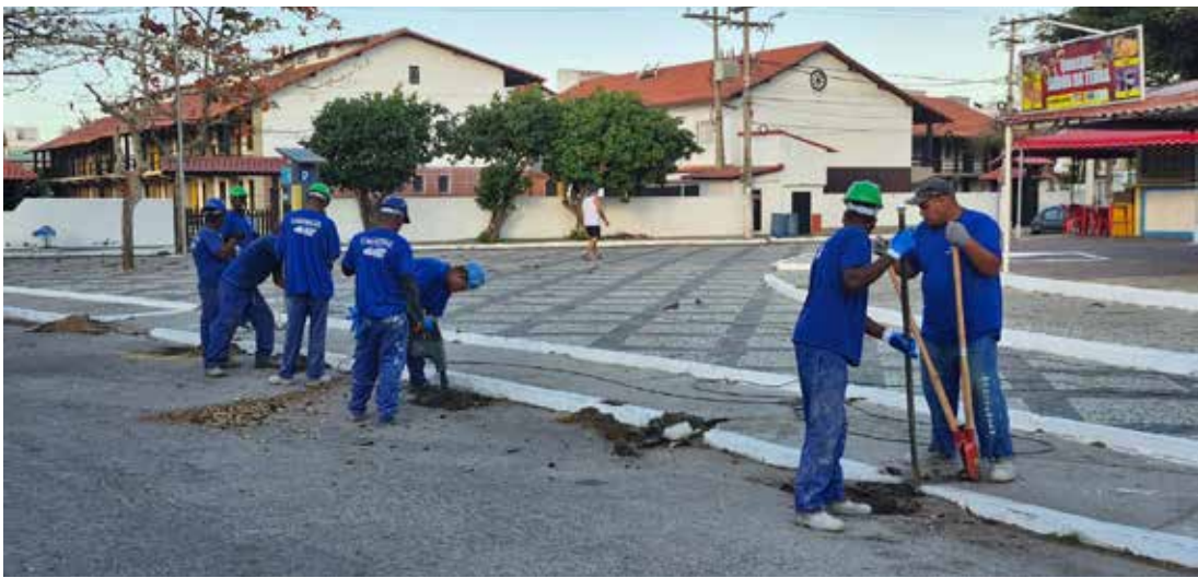
A Praça do Moinho já foi cercada para início das obras
