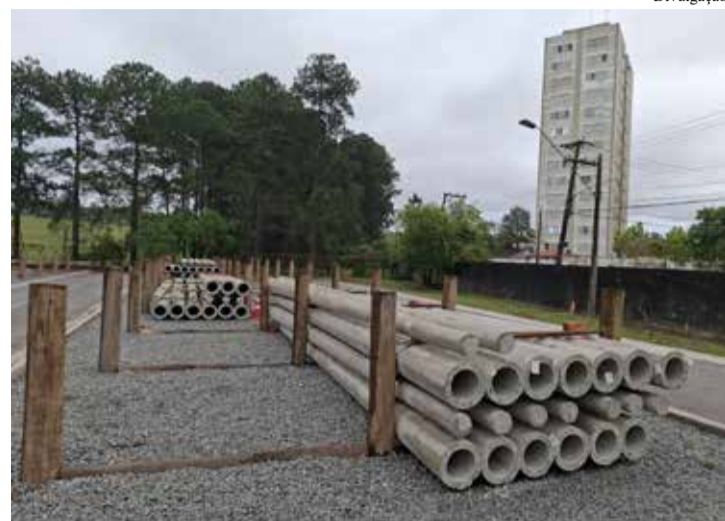
Postes, cabos, transformadores e outros componentes da rede elétrica ganham nova destinação.
